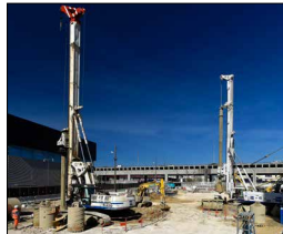
Deux ateliers de forage
