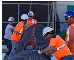
Assemblage de cages d'armatures d'un pieu
