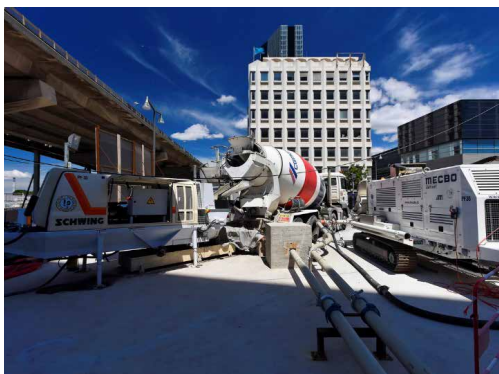
Aire de pompage du béton
